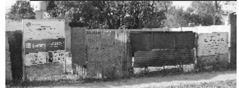
Frente del terreno donde se construirá el Salón para los socios del CIP de Merlo
